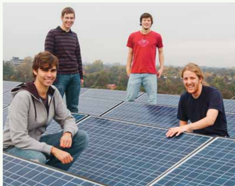
OBEN | Die HEG Heidelberger Energiegenossenschaft produziert eigenen Solarstrom.
